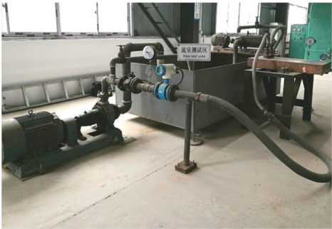
流量测试 FLOW TEST
